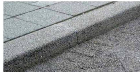
Betonstraatsteen en -banden met uitgewassen toplaag
