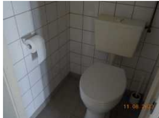
Foto 4: In het toilet zijn geen asbestverdachte toepassingen waargenomen.
