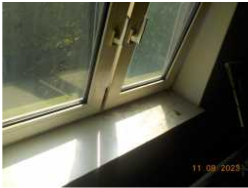
Foto 1: De vensterbanken zijn niet asbestverdacht.
