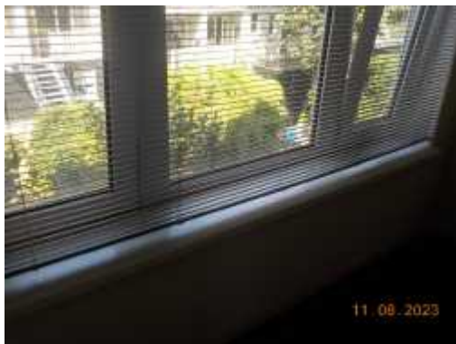
Foto 1: De vensterbanken zijn niet asbestverdacht.
