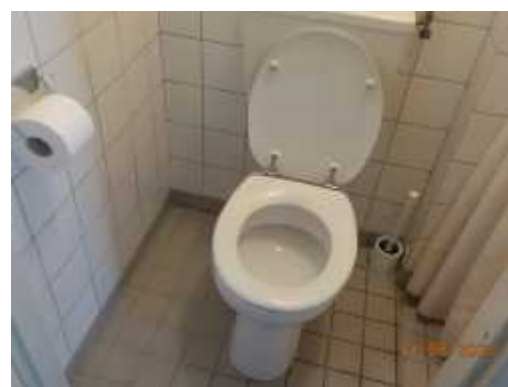
Foto 4: In het toilet zijn geen asbestverdachte toepassingen waargenomen.
