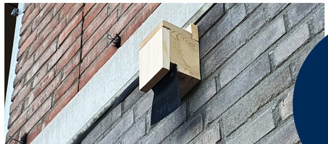
Houten kastje aan de gevel met exclusion flaps.
